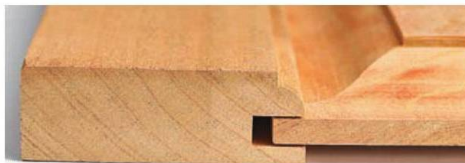
Филенка должна иметь зазоры по краям, а не упираться в дно шпунтов рамы, как видно на разрезе этой дверцы.
